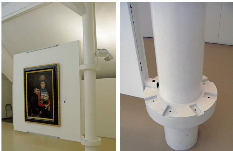
Fig. 25: Le système d'accrochage des panneaux aux piliers.
