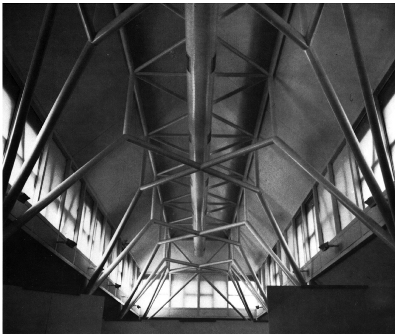
Fig. 18: La structure tubulaire de la charpente. © MAHF.
