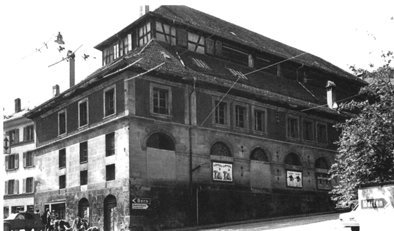
Fig. 1: Le bâtiment désaffecté des anciens abattoirs. © MAHF.
