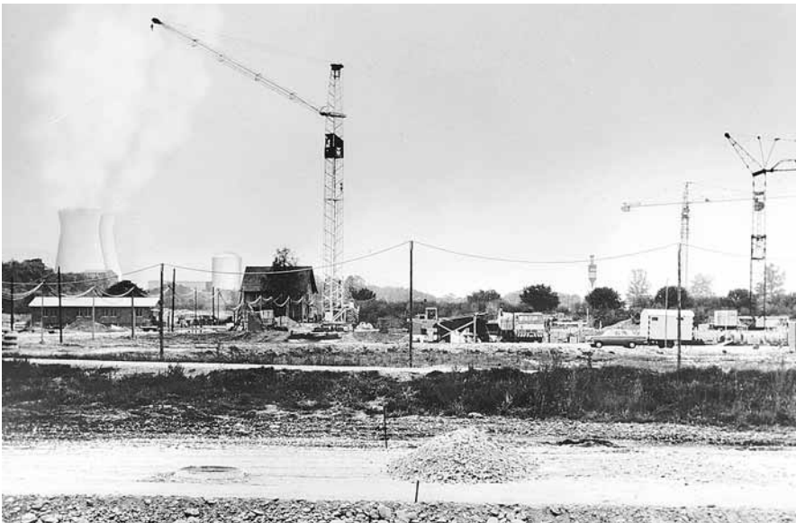
Abb. 9 und 10: 1972 erstellte die Motor-Columbus eine Serie von Fotomontagen, die das KKW Kaiseraugst mit seinen zwei Kühltürmen von verschiedenen Standorten aus zeigten. Oben: Blick von der Landstrasse am Dorfausgang Kaiseraugst. Unten: Blick von der Baustelle der Wohnsiedlung R1000 am Stadtrand von Rheinfelden. Quelle: ArK, R 3.1.7.
