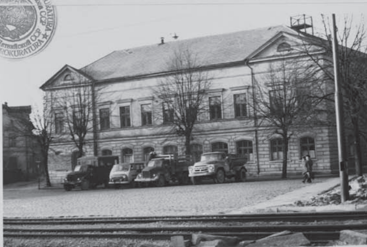
ФОТО № 33: Вид на бывшую Пожарную площадь города Лиепая со стороны ул. Ленина. Ездании на площади в настоящее время находится Лиепайский дом культуры.
