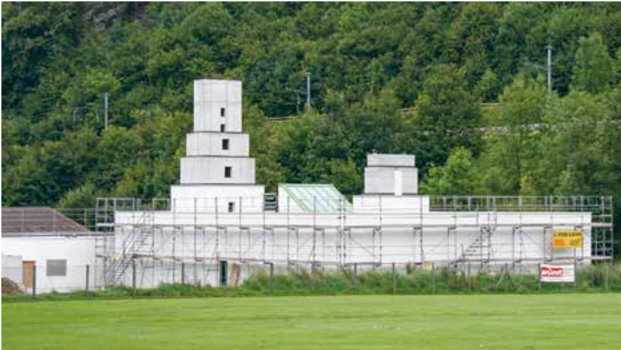
Abb. V 6: Der sich im Bau befindliche Torturm des Sri Maṅṅmani Ampāl Ālayam in Trimbach (11.08.2009).
