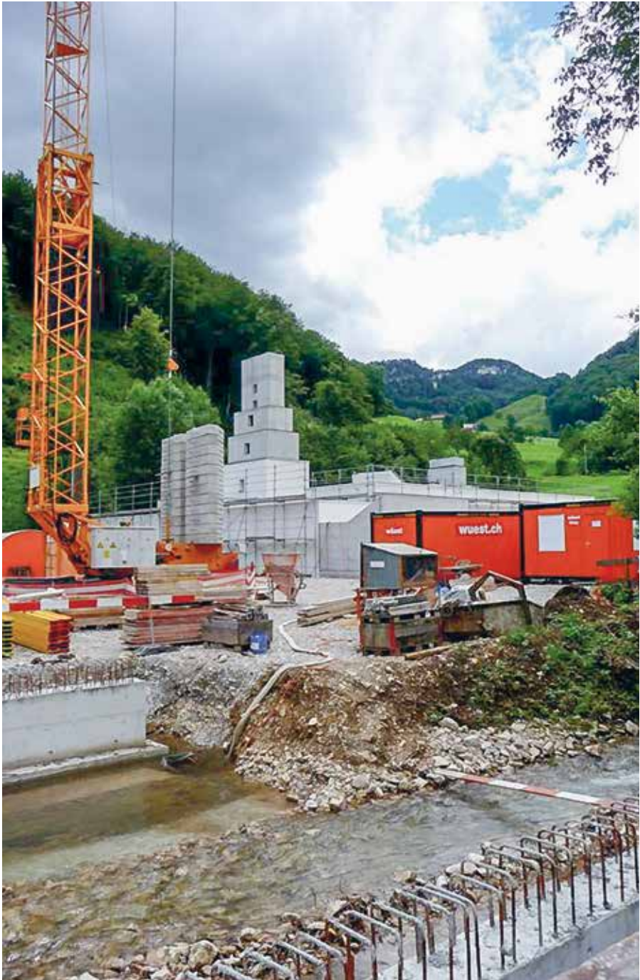
Abb. IV 14: Bauphase des Sri Mañōnmani Ampāl Ālayam in Trimbach (04.03.2010).
