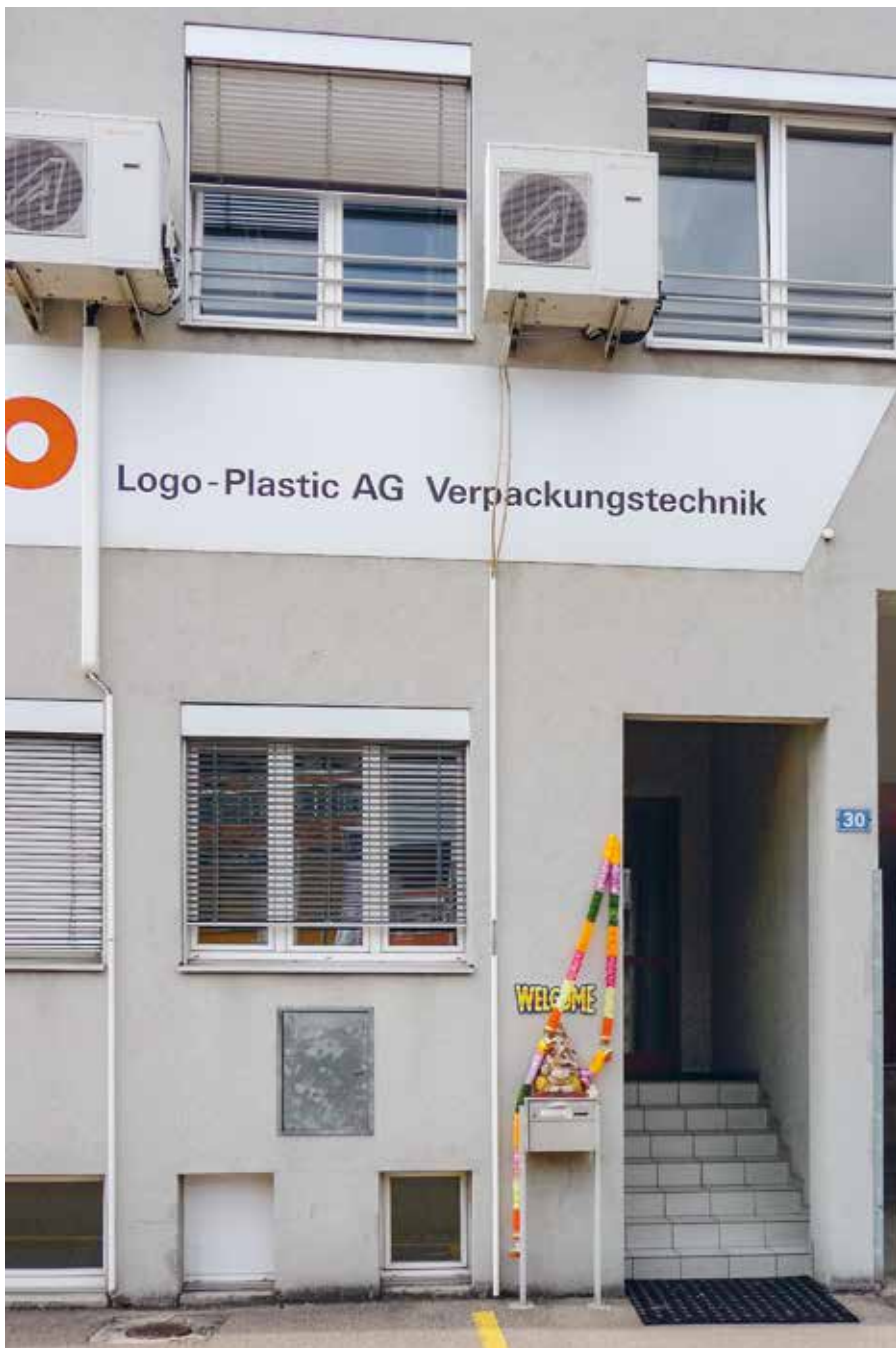
Abb. IV 12: Eingang des Basler Hindu-Tempel im käuflich erworbenen Gebäude im Dreispitzareal (08.04.2009).
