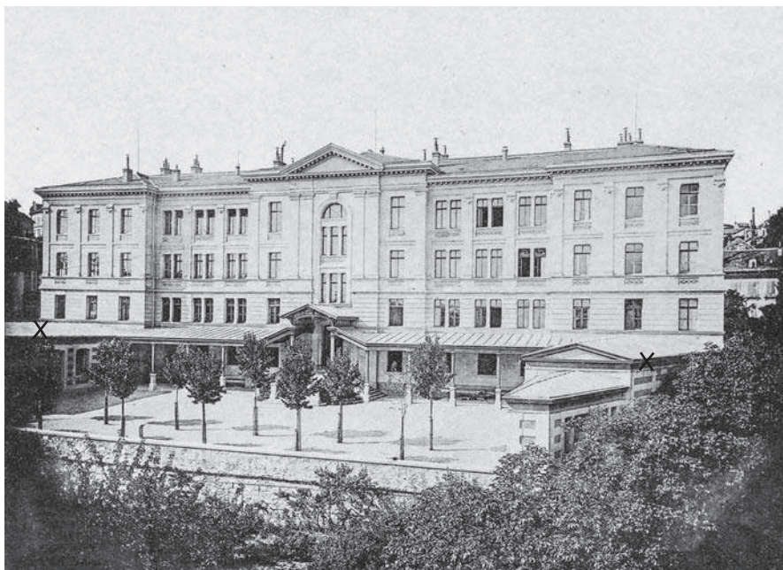
Fig. 8-4: Lausanne, Anonyme, École supérieure de jeunes filles de Villamont, photographie, vers 1890. Les salles de gymnastique sont des constructions séparées, situées à l'avant, de part et d'autre de la cour (X).
