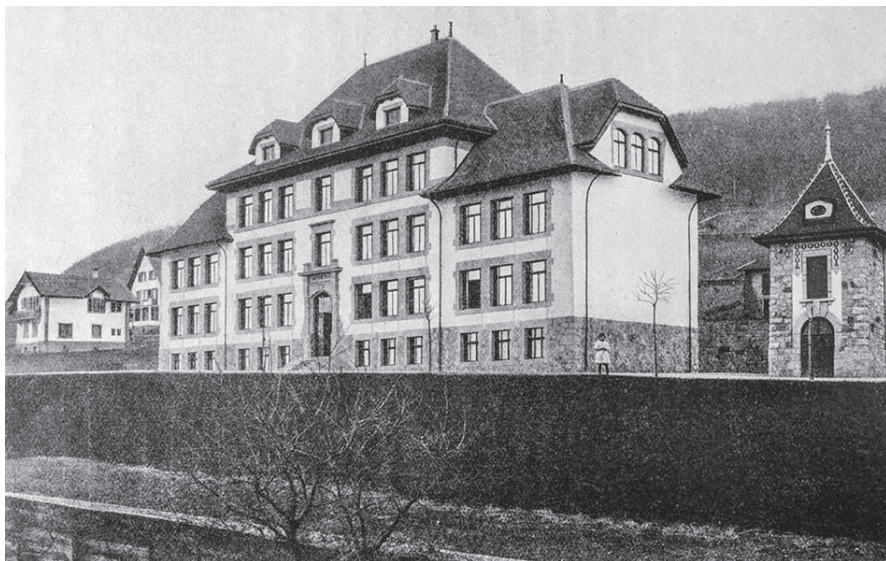
Fig. 8-28: Peseux (NE), collège des Guches, construit en 1914.
