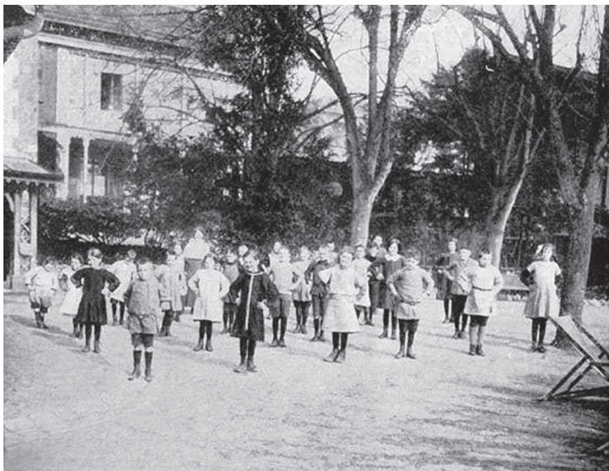
Fig. 5-22 : Lausanne, classe de culture physique et de cure d'air et de soleil, service sanitaire scolaire, entre 1915 et 1917.
