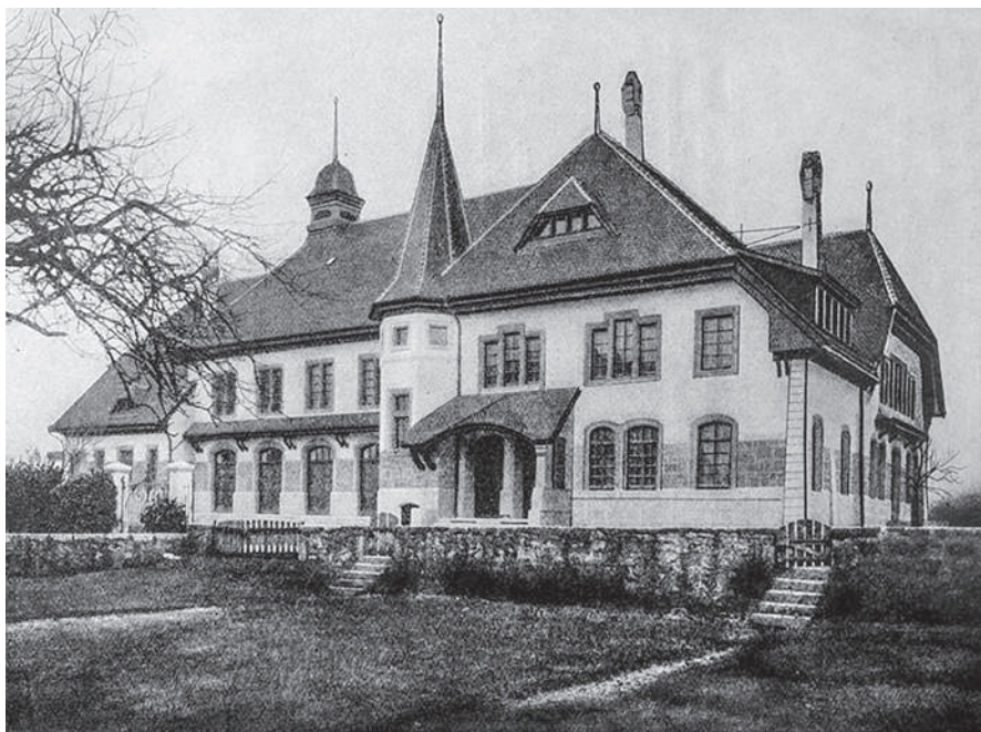
Fig. 8-27: Peseux (NE), grande salle - halle de gymnastique, construites en 1914.
