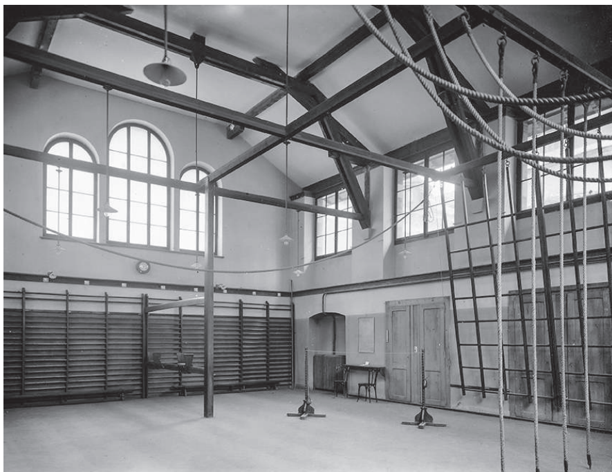
Fig. 8-33 : Genève, salle de gymnastique de l'école de Malagnou, s. d.
