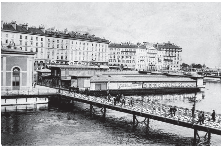
Fig. 5-9: Pont de la Machine et Bains du Rhône, auteur inconnu.
