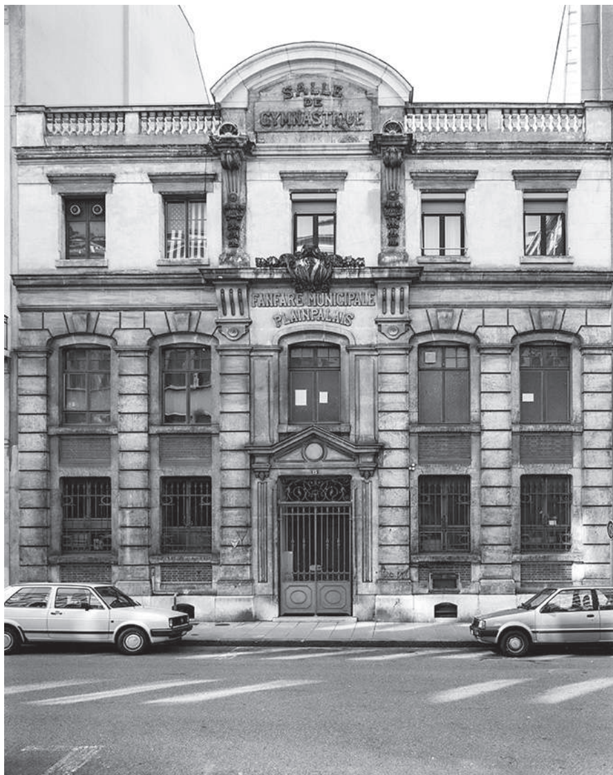
Fig. 8-16: Genève, salle de gymnastique, rue des Vieux-Grenadiers, photographie, deuxième moitié du xx e siècle.
