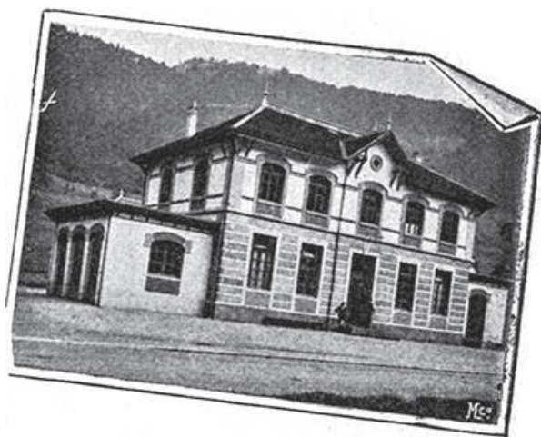
Fig. 8-23: Saint-Sulpice (NE), salle de gymnastique construite en 1899.
