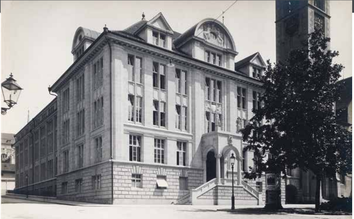
«Ein Stahlbetonbau in zeitgemässer Konstruktion, seine Ästhetik sachlich bestimmt», wird der Bibliotheksneubau von 1917 in der Fachliteratur beurteilt.
