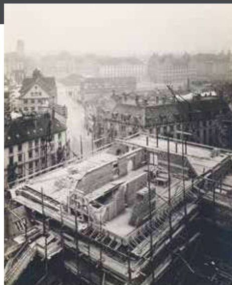
Blick über die Baustelle in Richtung Urania.
