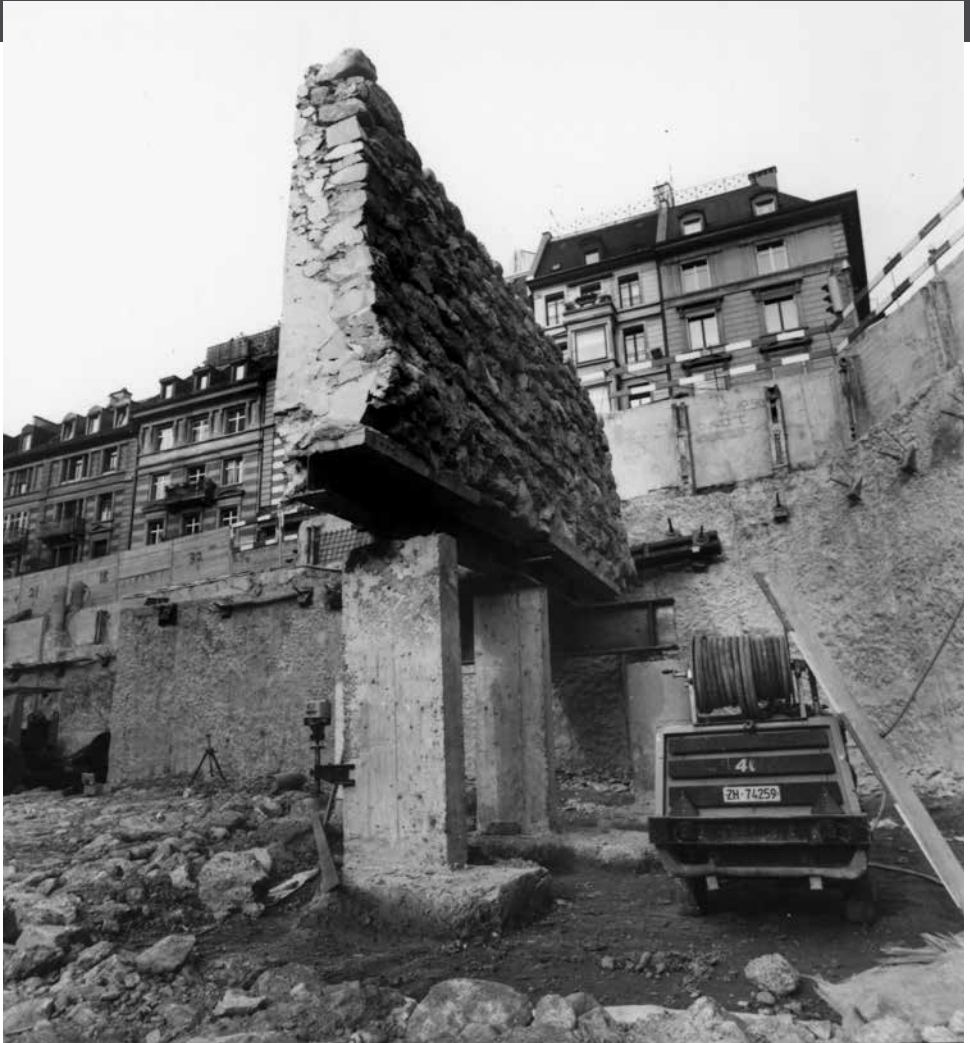
Reste der Stadtmauer, die im Untergeschoss des Neubaus erhalten blieben.
