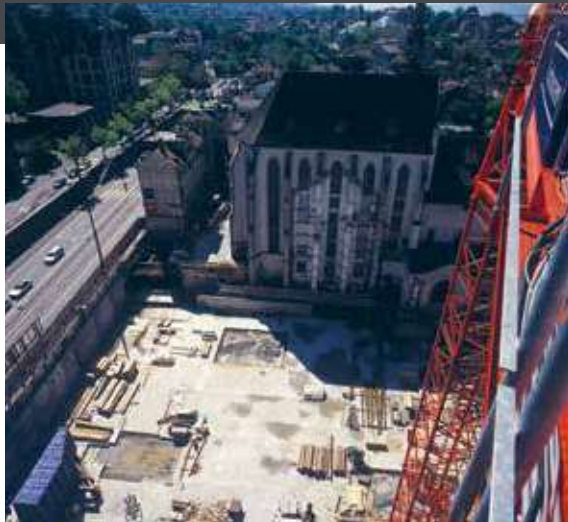
Grossbaustelle zwischen Mühlegasse und Predigerkirche, bis hinauf zum Seilergraben (links), fotografiert 1990.
