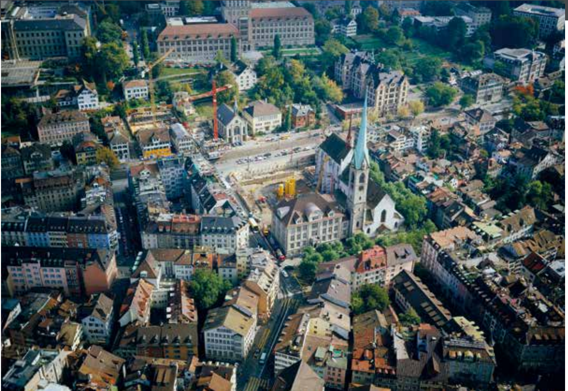
Luftaufnahme der Baustelle, 1990.
