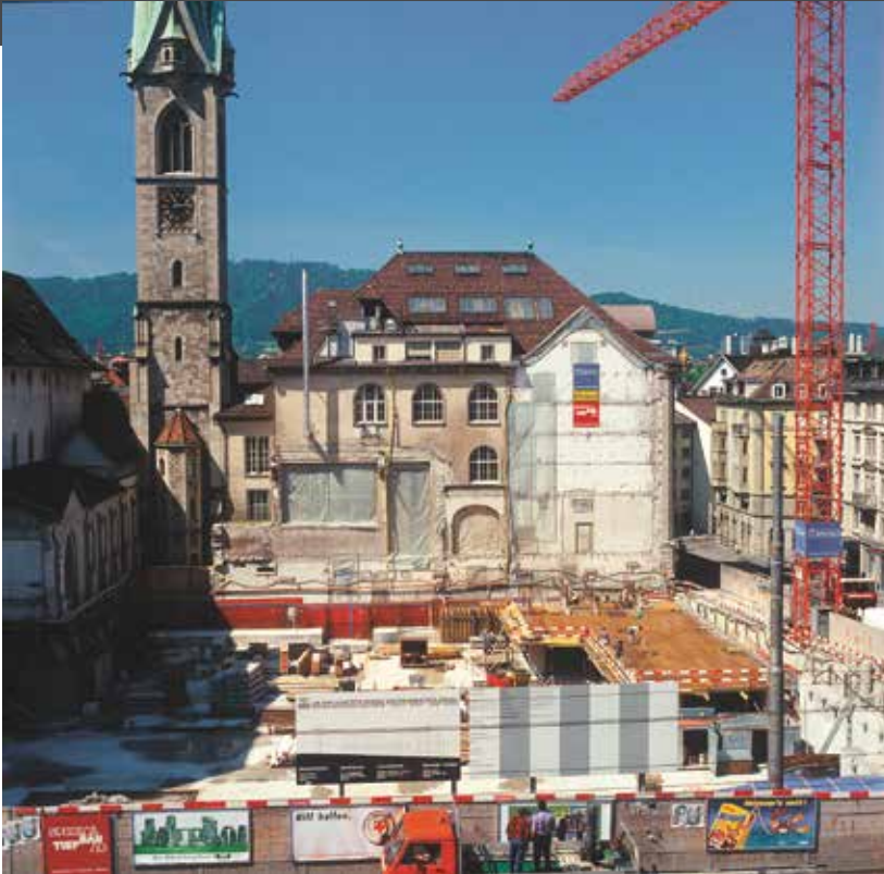
Blick auf die Baustelle und das alte Verwaltungsgebäude von 1917.
