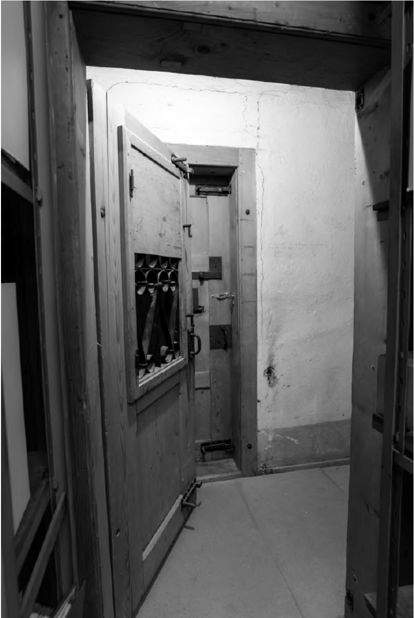
Blick vom Gang des Dachbodens durch die erste verschliessbare Tür. Dahinter befindet sich eine der drei Zellentüren.
