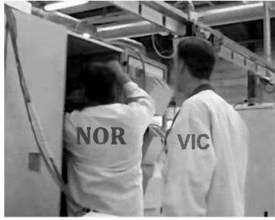
Figure 5: NOR effectue diverses vérifications visuelles et des interventions dans l'armoire.
