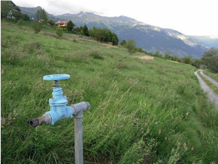
Vanne du réseau d'irrigation sur les prairies de Montana-Village, en Valais (Martin Calianno).
