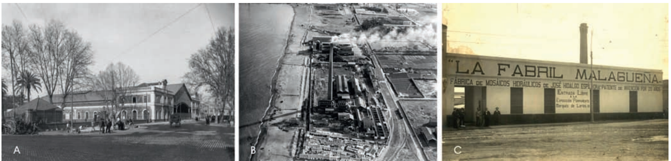
Fig. 3 a) Malaga, Antica stazione della ferrovia , 1940 ca. Fonte: Archivio Manuel Ocón Dueñas; b) Società Metallurgica di Piombo "Los Guindos" , 1940. Fonte: https://www.facebook.com/groups/solofotosantiguasdemalaga/?ref=ts , e c) "La fabril Malagueña" , s.d.; s.a. Fonte: Archivio Diaz de Escovar (Malaga).
