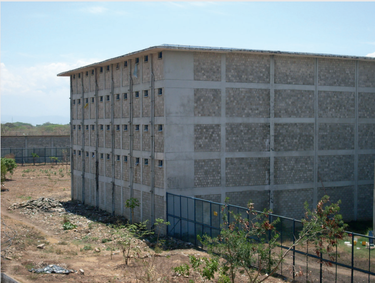
Quartier d'hébergement de la prison de haute sécurité de Valledupar, située dans une zone semi-aride et isolée du nord de la Colombie, 2009 (source : FCSP).
