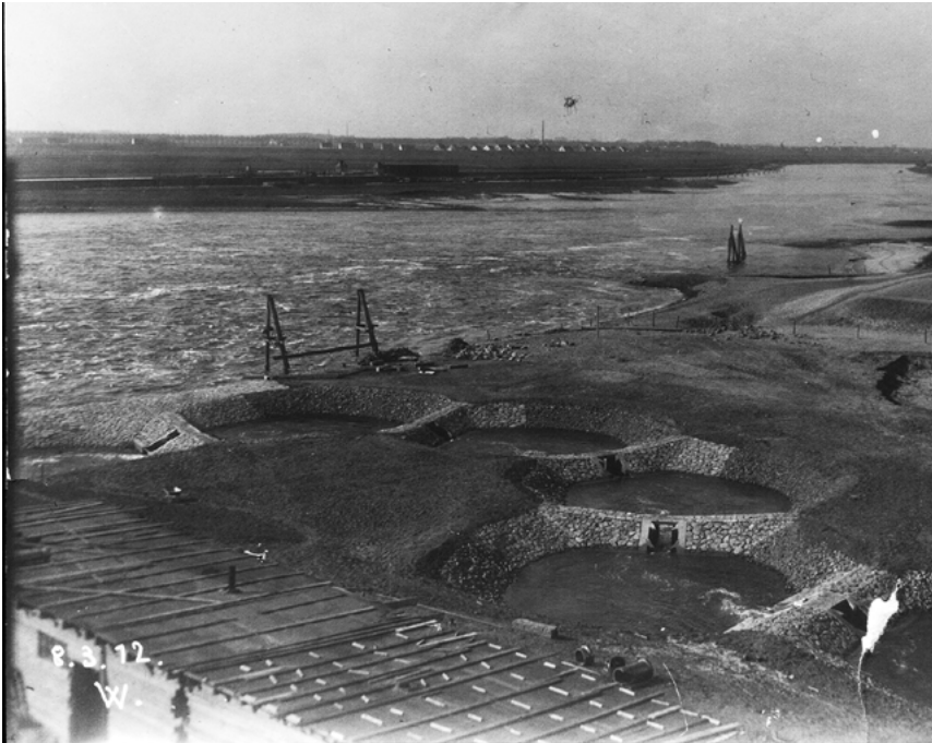
Abb. 3: Der Wildpass am rechten Weserufer, der aus mehreren Rundbecken bestand, die über schmale Schlupflöcher mit rippenartigen Ausbuchtungen verbunden waren. Die Bauweise trug die Handschrift des norwegischen Fischereiexperten Landmark. (Anonym, Bau des Weserwehrs 1909–1912, 8. 3. 1912, Bremer Staatsarchiv, Fotoalben: 10, B AL, Signatur 1520)
