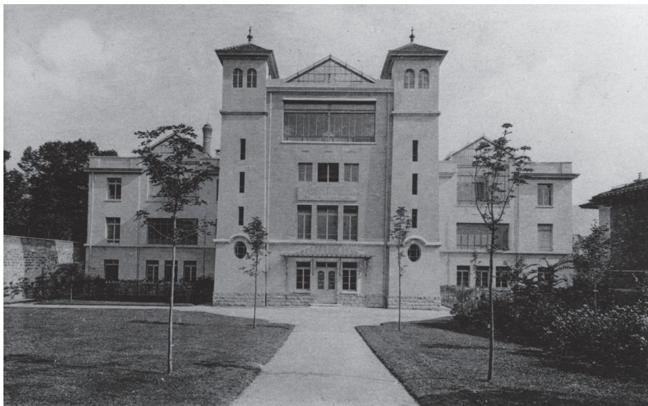
Figure 1: Pavillon opératoire de la clinique chirurgicale construite en 1913.
