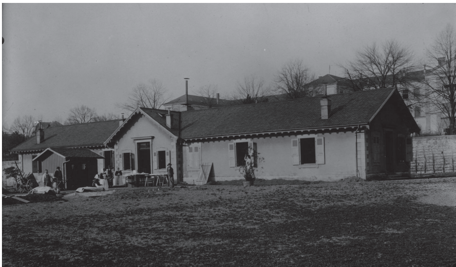
Figure 6 : Bâtiment d'isolement inauguré en 1886 et situé en contrebas de l'Hôpital cantonal, dans le potager, à quelques mètres du mur d'enceinte du jardin de l'Hôpital.
