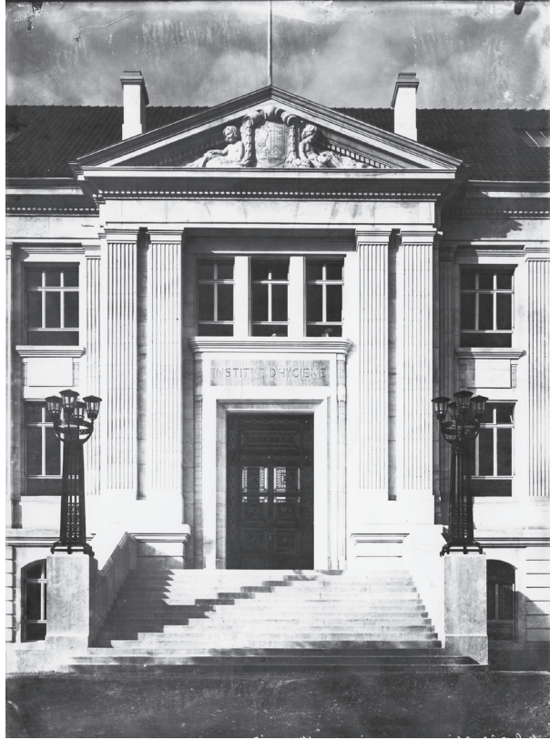
Figure 4 : Institut d'hygiène (1914) sur les plans de l'architecte Alfred Ouvet.
