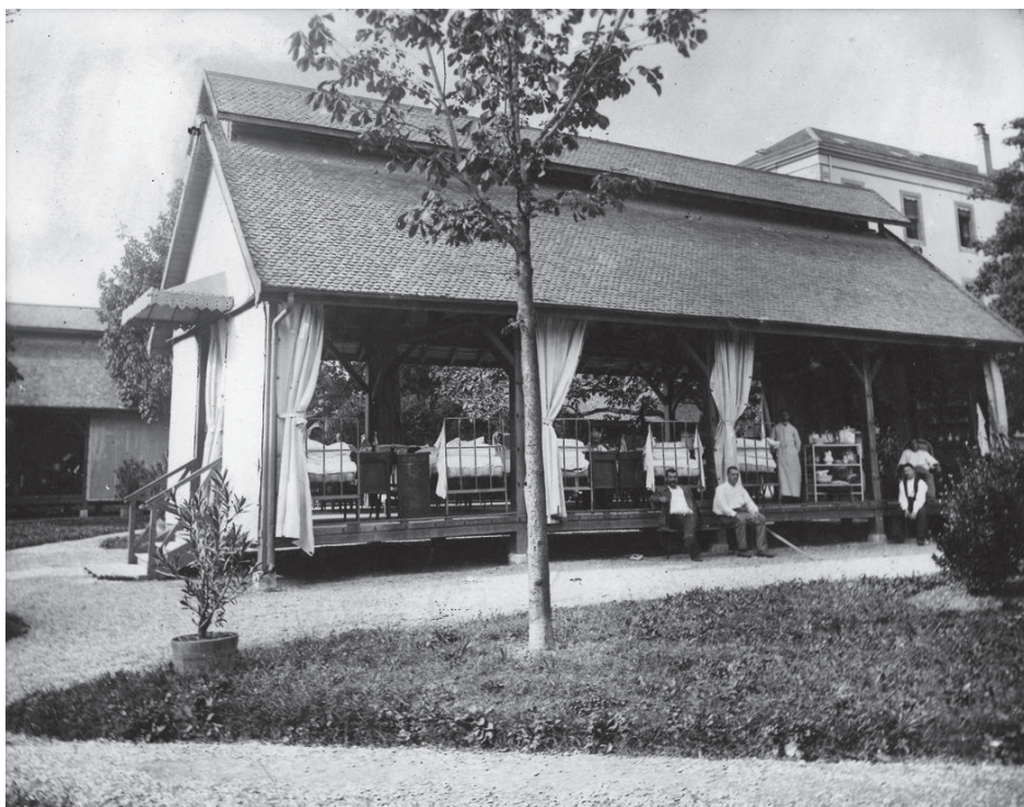
Figure 14 : Pavillon de chirurgie conçu par Gustave JULLIARD. Le premier est érigé en 1871.
