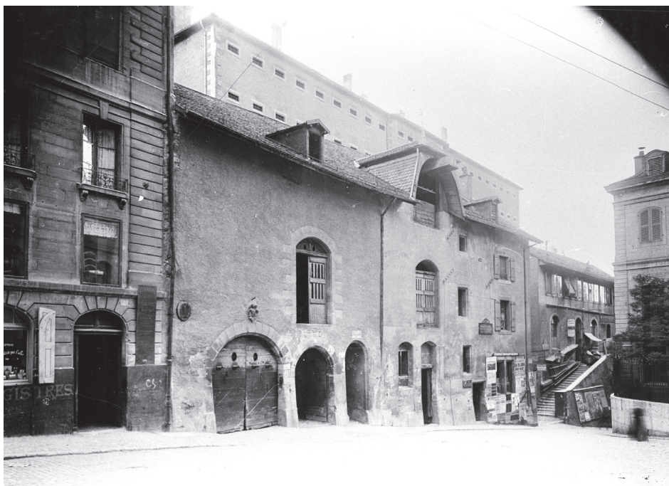
Figure 5 : Petit Hôpital, dépendance de l'Hôpital général située en face et en contrebas du bâtiment du Bourg-de-Four telle qu'elle était encore au début du XX e siècle 85 .
