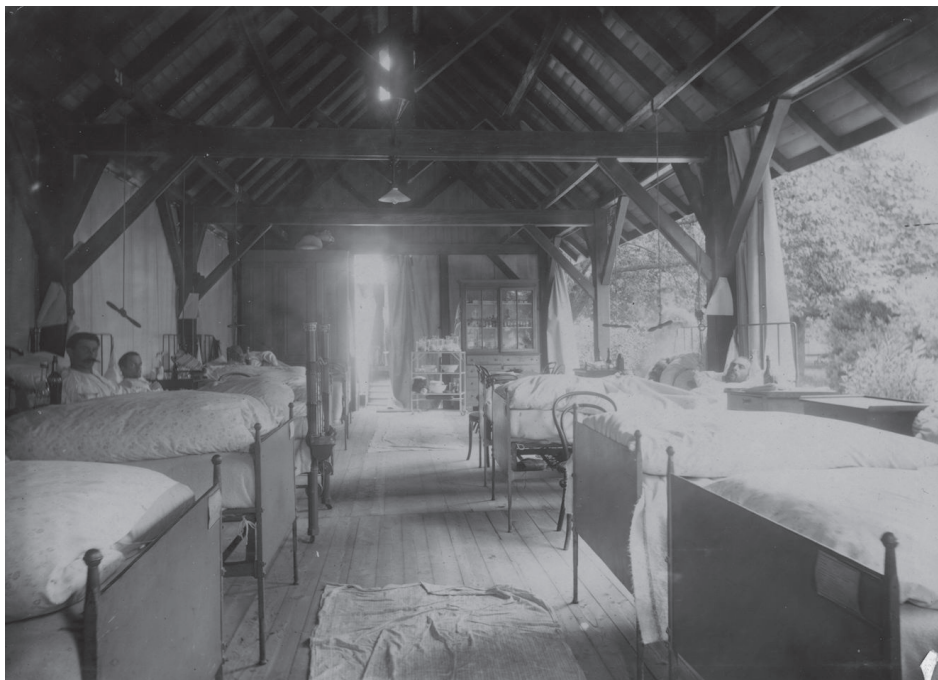
Figure 15: Vue intérieure de l'un des pavillons de JULLIARD.
