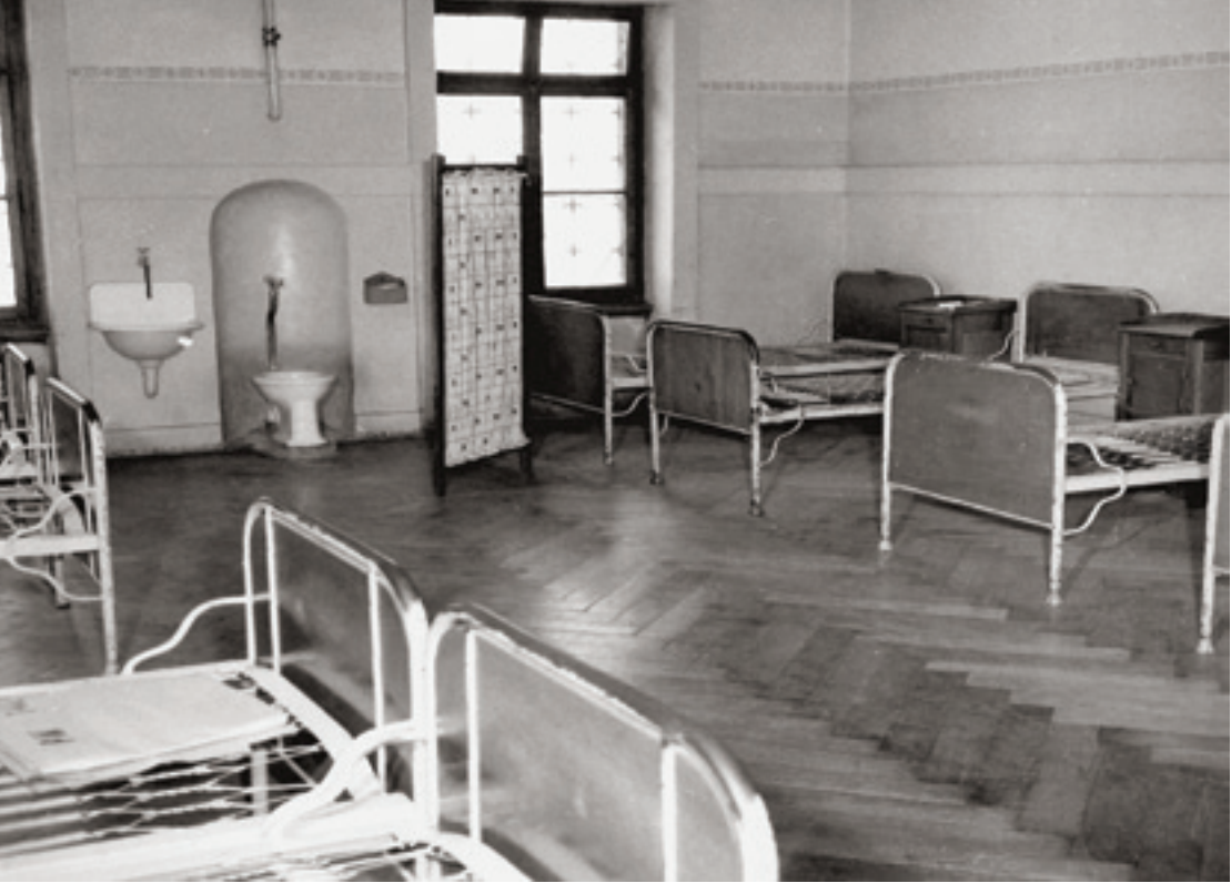
Asile de Cery, chambre avant démolition. Ces dortoirs impersonnels et insalubres ne répondant plus aux exigences médicales et aux souhaits des patient.es ont été détruits en 1970.
