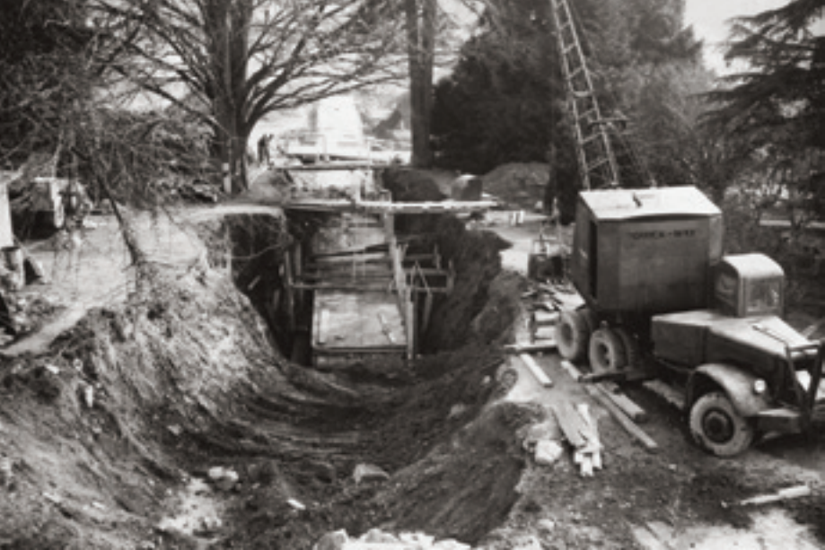
Construction du tunnel reliant l'ancien asile à la Nouvelle clinique, circa 1955.
