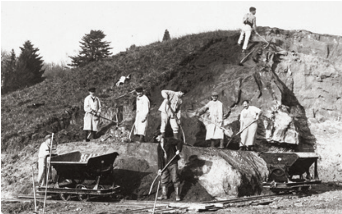
Travaux de terrassement à Cery pour lesquels sont employés des patients, début 20 e siècle.
