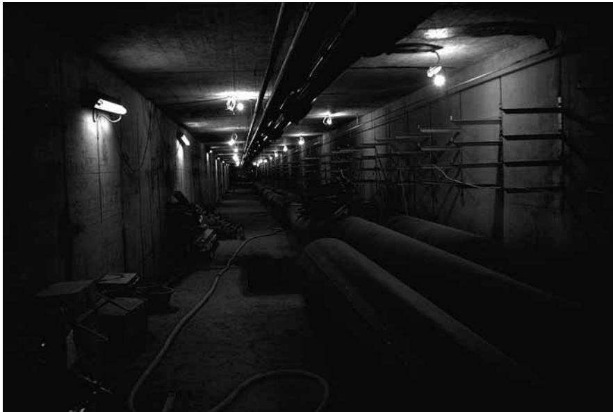
Abb. 18: Zugangsstollen zur Lucens-Reaktorkaverne (AKS, Nachlass Ribaux, 322.6).
