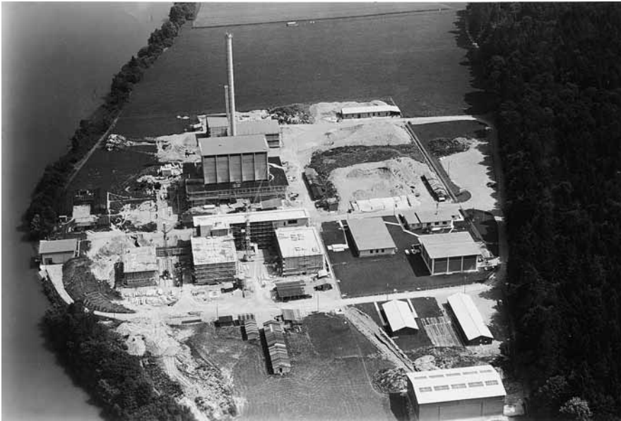
Abb. 5: Reaktor AG im Bau. Hinten der Diorit, im Vordergrund das Forschungslabor (AKS, Nachlass Zünti).
