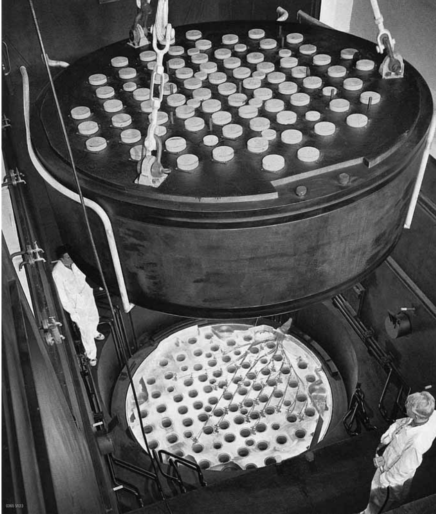
Abb. 22: Montage der oberen Reaktorabschirmung des Lucens-Reaktors durch Sulzer-Mitarbeiter (GB Sulzer 1965, S. 11).
