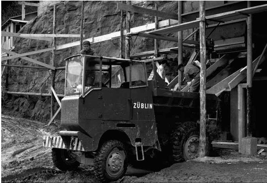
Abb. 16: Betonierarbeiten am Zugangsstollen von Lucens (AKS, Nachlass Ribaux, 322.6).
