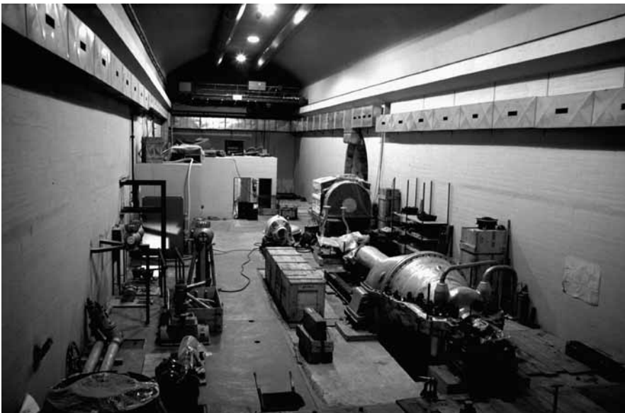
Abb. 24: Montage der Kraftwerkskomponenten in der Maschinenkaverne (AKS, Nachlass Ribaux, 322.6).
