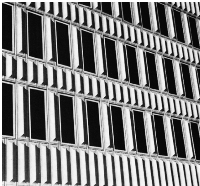
Abb. 22: «Fenster und Fassade dieses Bürogebäudes bestehen aus erhöht schlagzähem PVC.» Die 1970 gegenüber den Anfängen bei J. H. Benecke längst perfekt stabilisierten Oberflächenverkleidungen aus PVC konnten nicht verhindern, dass die Nachricht der VC-Kanzerogenität Kratzer auf dem Image des Kunststoffs hinterließ. Foto in: Kunststoffe , 60 (1970) 8, 532.
