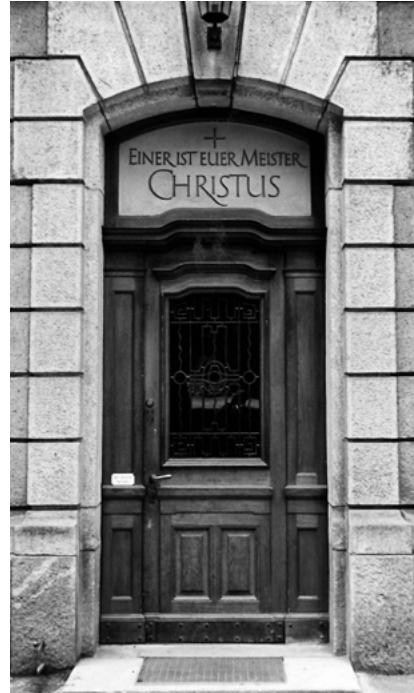
Abb. 1: Ehemaliger rückseitiger Tür- eingang. (AU, Zeller, Verschiedenes 12, Nr. 2.)
